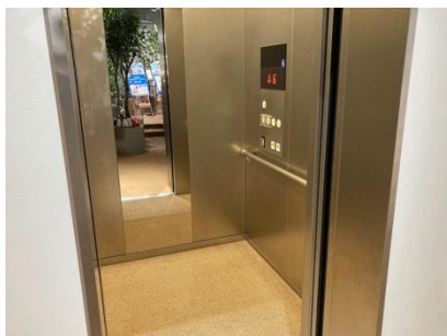
エレベーター
